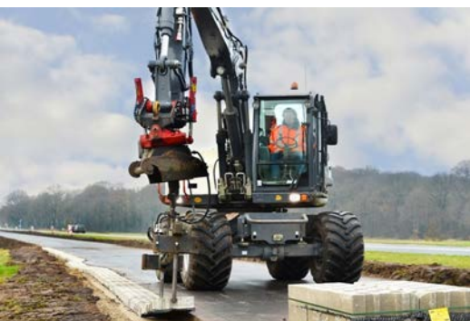
Er is ook een proeftuin Geopolymeren. Op de foto: samen met Sqape is v.d. Bosch Beton er in geslaagd om het cement in betonnen graselementen (bermverharding) te vervangen met behulp van de Sqape-geopolymeertechnologie.
