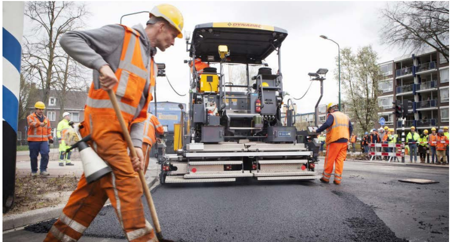
In de proeftuin Asfalt Deklagen worden SMA deklagen met 30 tot 50 procent PR gemonitord wat leidt tot een nadere onderbouwing voor deze duurzame toepassingen.
