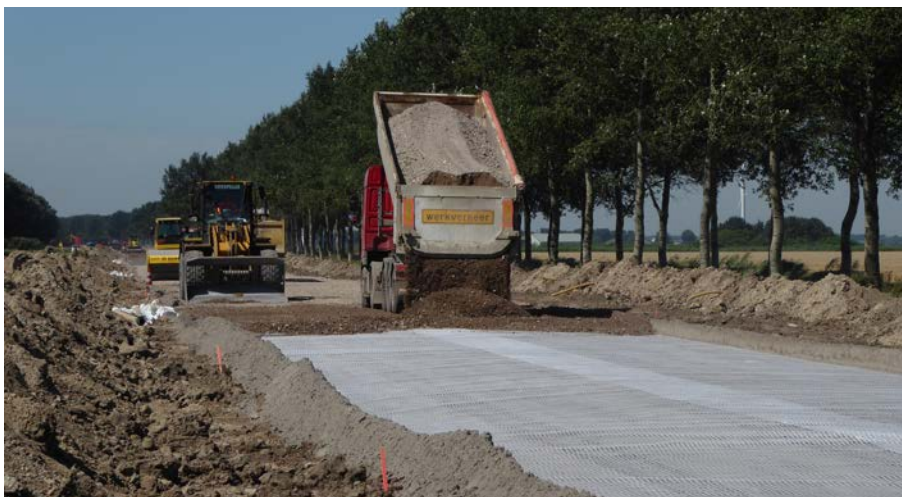
Met de deelnemers van BouwCirculair is een proeftuin Circulaire Wegfundatie ingericht.
