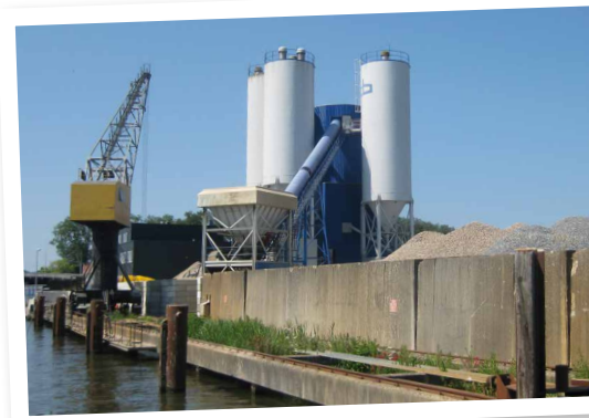
▲ Betonmortelcentrale in Diemen. (foto: Wikimedia/ Marion Golsteijn)
